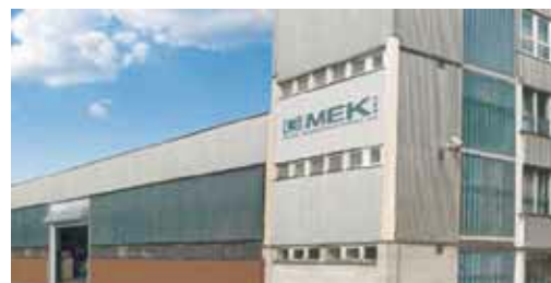
Будапешт – Венгрия. Производственное предприятие (Gimek Zrt).
